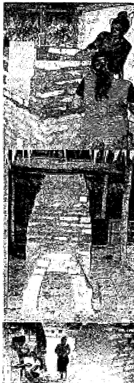
Acabado de construcción y prueba de quemado en horno prototipo. Fotos C. Calbache.
