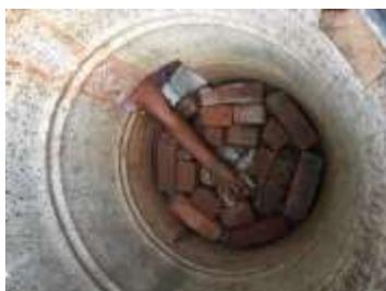
Se procede a hacer una cama en ladrillo sobre la base del tanque metálico, que luego se recubre con arcilla.
