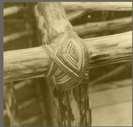
Nudo de pilde Nudo usado sobre la guadua para unir la madera, base de la artesanía en los muebles.
