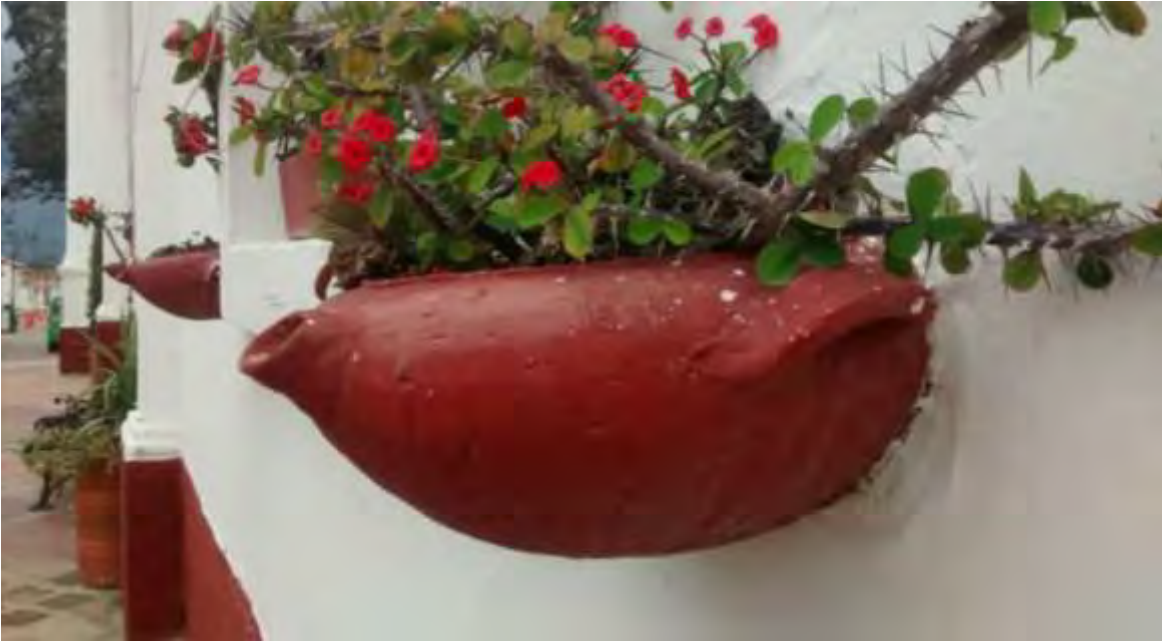
Maseteros de pared. Objeto de uso común que se encuentra en las fachadas de las casas. Es reconocido y popular entre la comunidad, se lo observa sobre las casas haciendo parte de la arquitectura y decoración del pueblo. Fotografía: Pablo Borchers.
