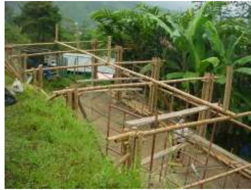
Foto: JHON AGUASACO Artesanías de Colombia Ibague – Tolima Planta de descortezado, falta instalación del techo Diciembre de 2007
