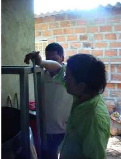
Foto: JHON AGUASACO Artesanías de Colombia Valledupar Cesar Centro de tintura Problema con la palanca de volteo de la marmita Diciembre de 2007
