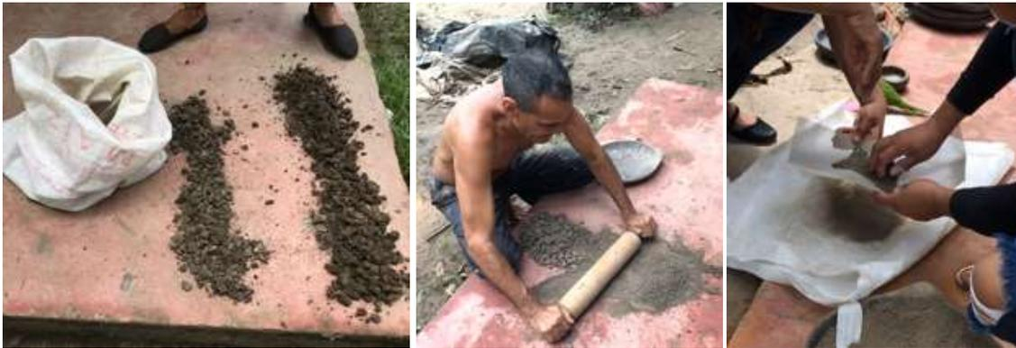
Preparación del Barro Gallego para mezcla en seco
