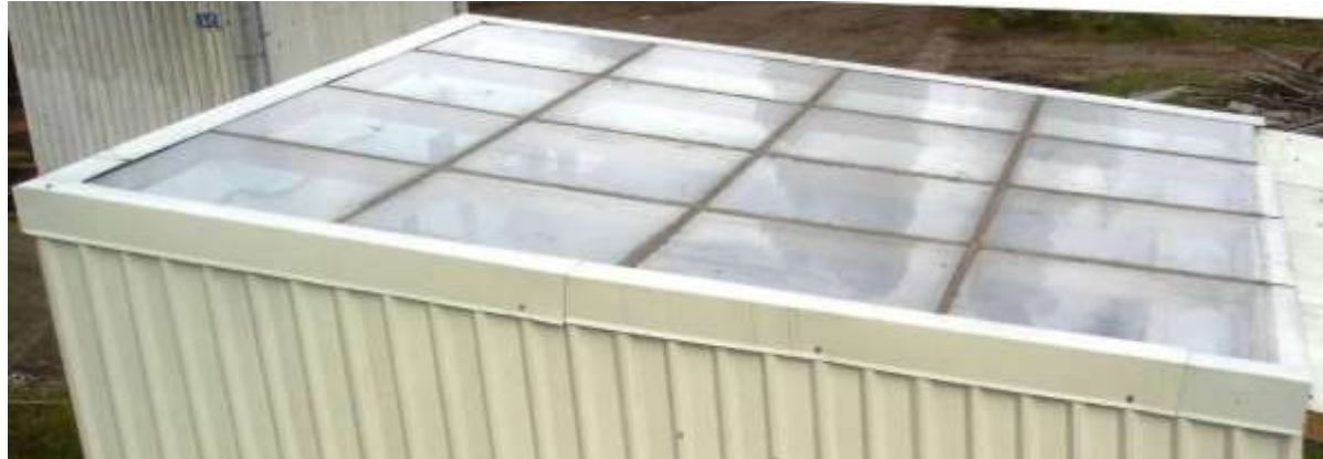
Vista superior del techo instalado
