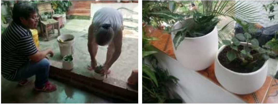
Figura 61. Impermeabilización de materas, Salazar.
