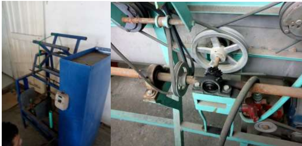
Anserma, grupo Seda y punto Mantenimiento, modernización equipos Fotos: Jairo Saavedra Anserma, Caldas, abril de 2018
