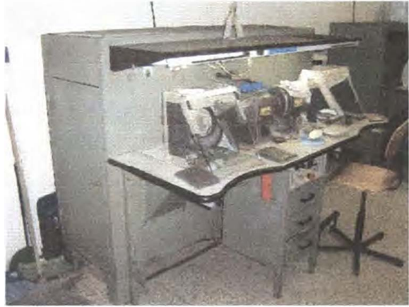
Fig. 33. Extractor con puestos de pulimento.
