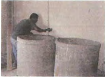
Instalación de tanques contenedores con suministro de aguas lluvia, (recicle y almacenamiento de tintes)
