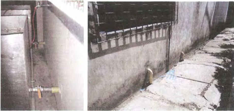
Instalaciones para red hidráulica y desagüe.
