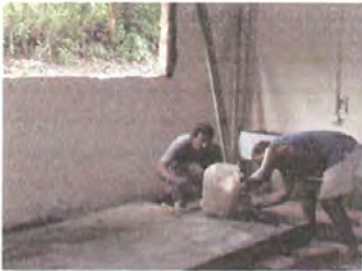
Acondicionamiento de áreas de trabajo y plataforma para calderas
