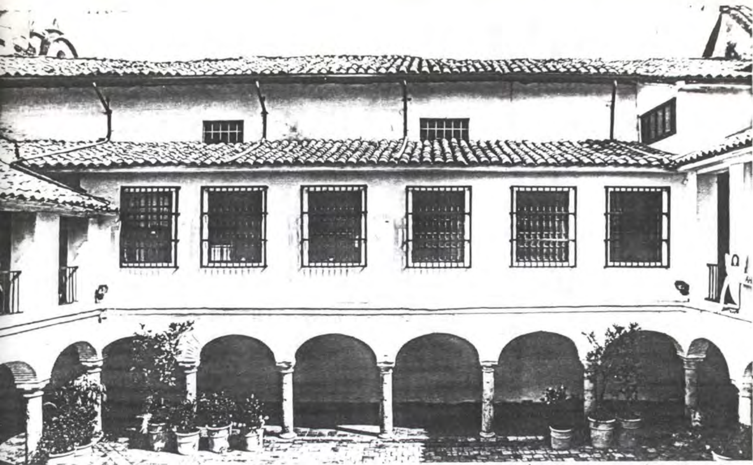
Claustro, lado norte, Feb. /91 (semidumbre de desagües de la iglesia)
