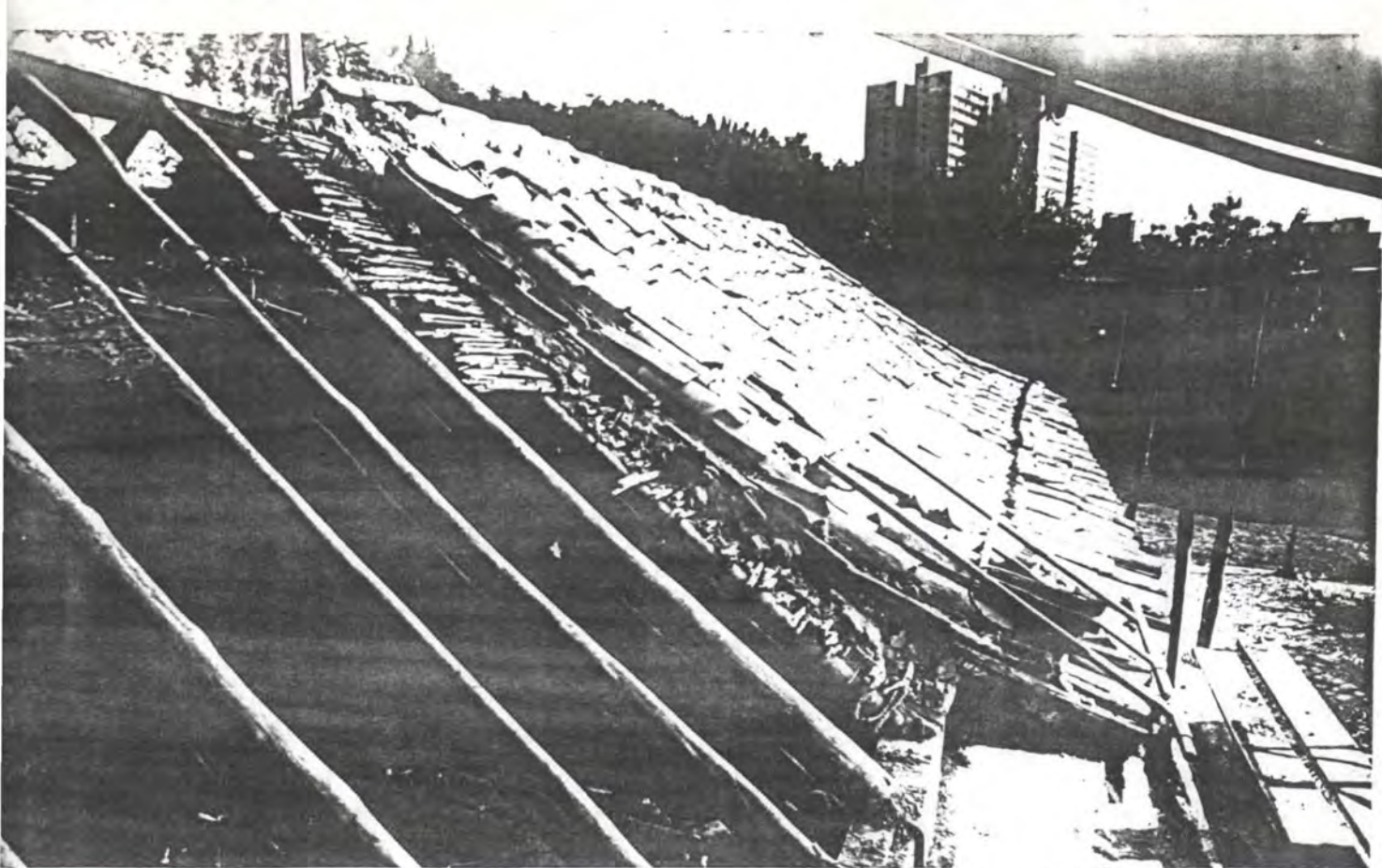
Desmonte de cubierta, lado occidental. 1992.
