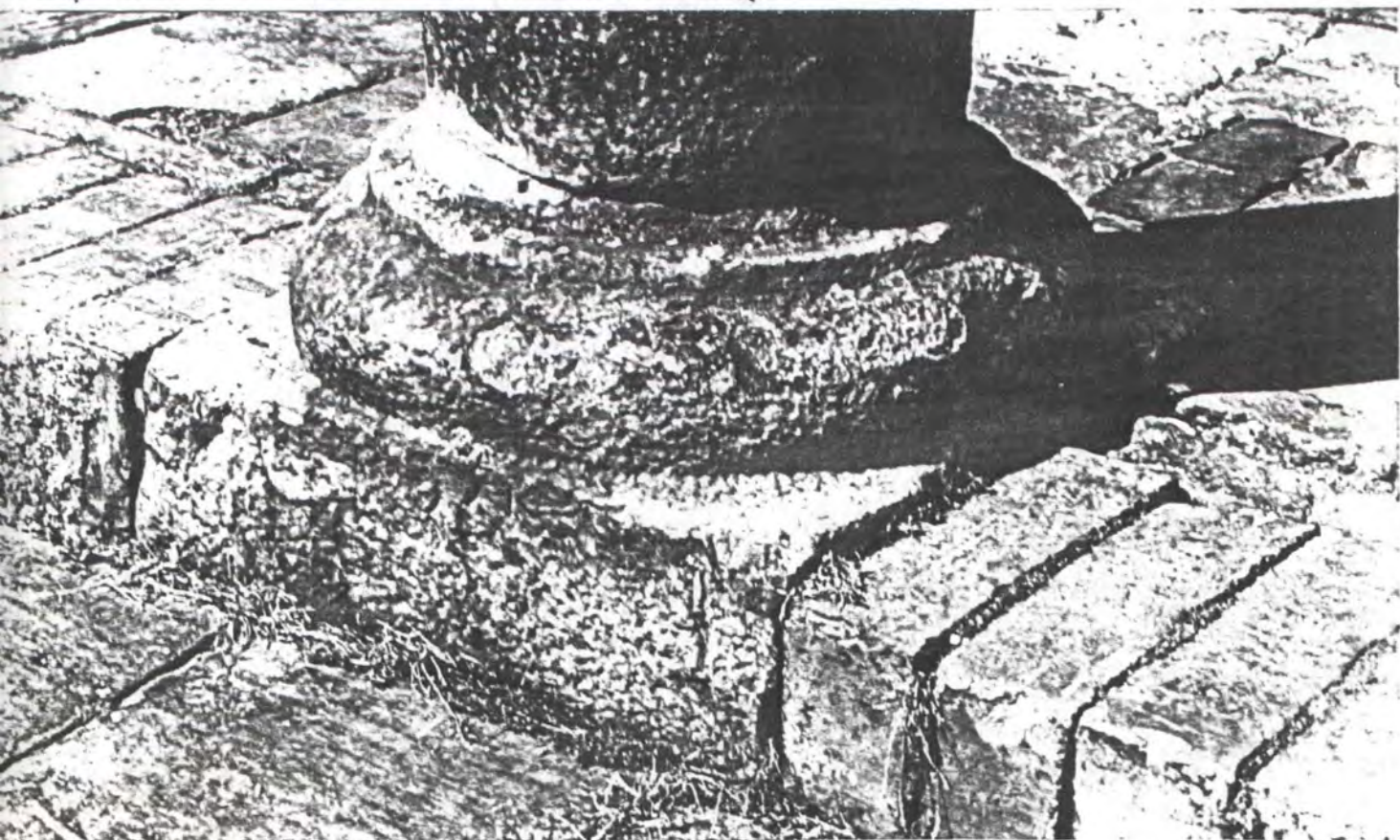
Capitel invertido, usado como base de columna.
