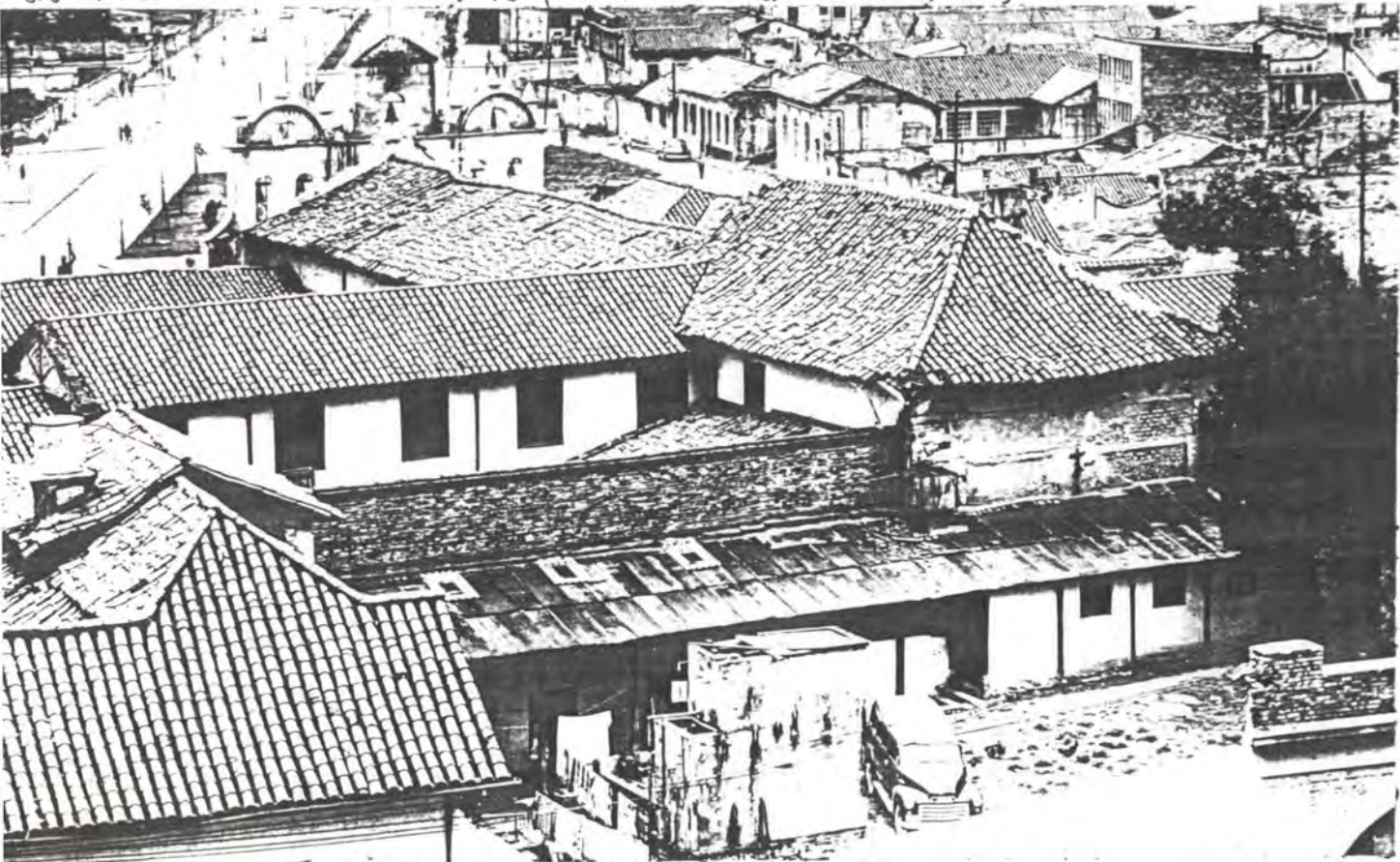
Detalle de la iglesia de las Aguas y pabellones adosados a ésta, incluyendo sobre-elevación de finales del siglo XIX, zócalo de comienzos del XX y galpones recientes. (foto G. Téllez, 1965)
