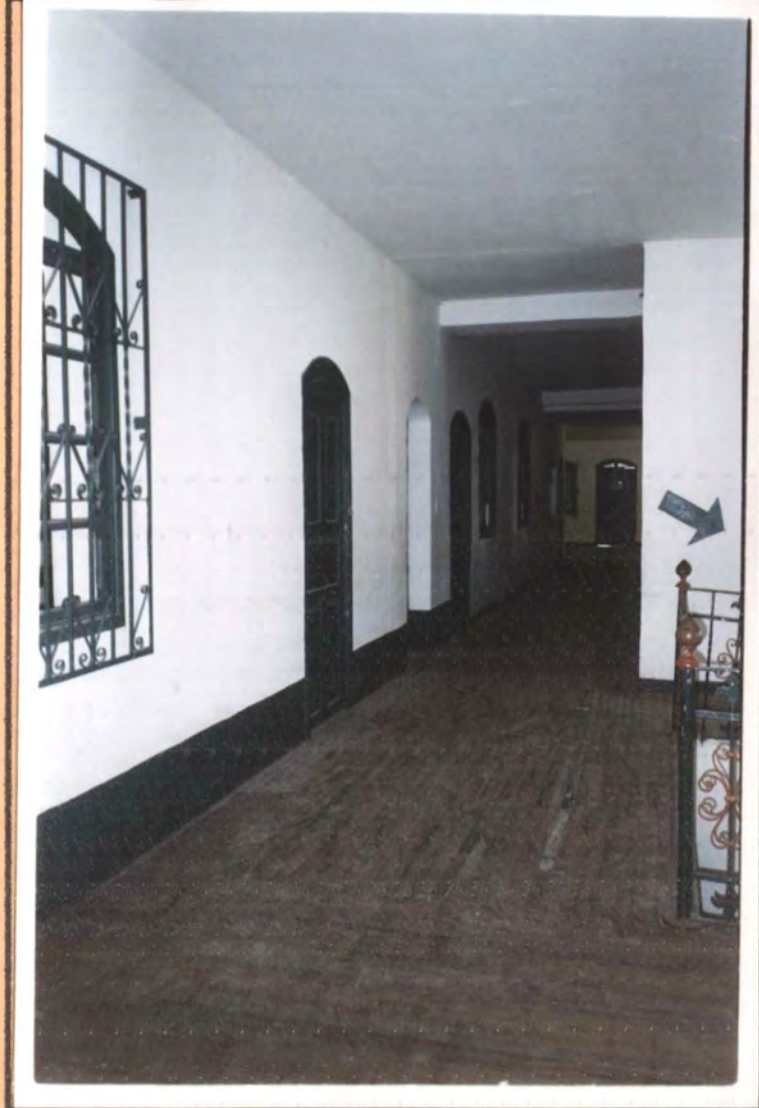
Corredor posterior de acceso al salón destinado. Instalaciones del Antiguo Colegio Departamental
