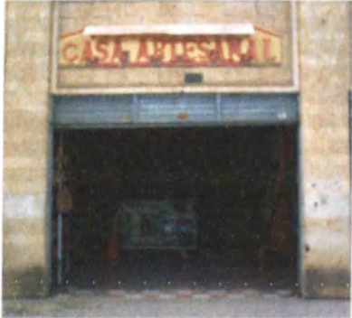
Entrada principal al Almacén
