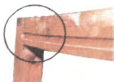
Ensamble de caja entre la chambrana y la pata
