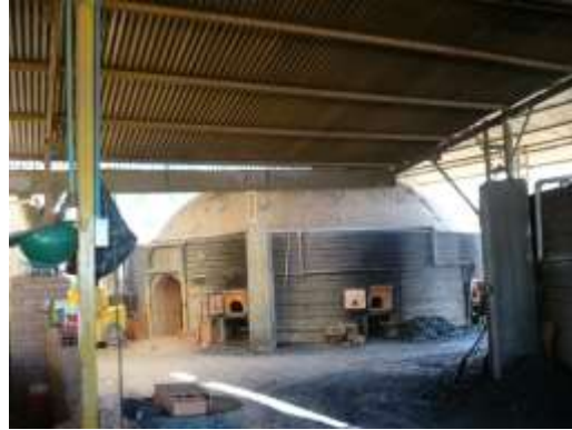
IMAGEN 1. Horno para quemar productos estructurales
