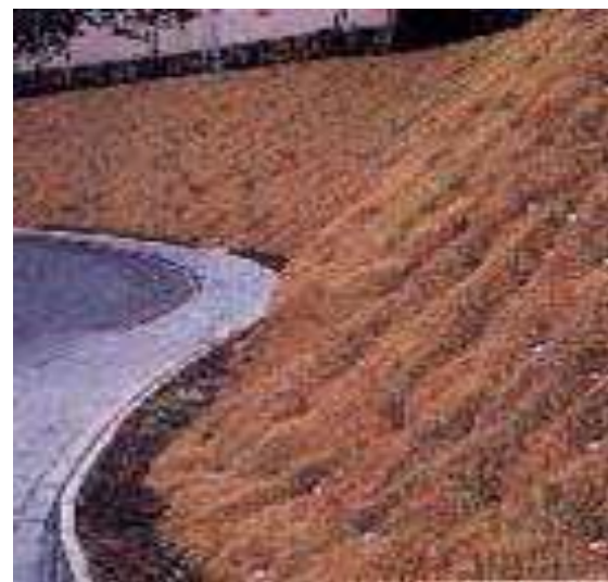
Fotos 50 y 51. Detalle de taludes cubiertos con malla tejida en fibra de coco anclada mediante estacas (España) 56
