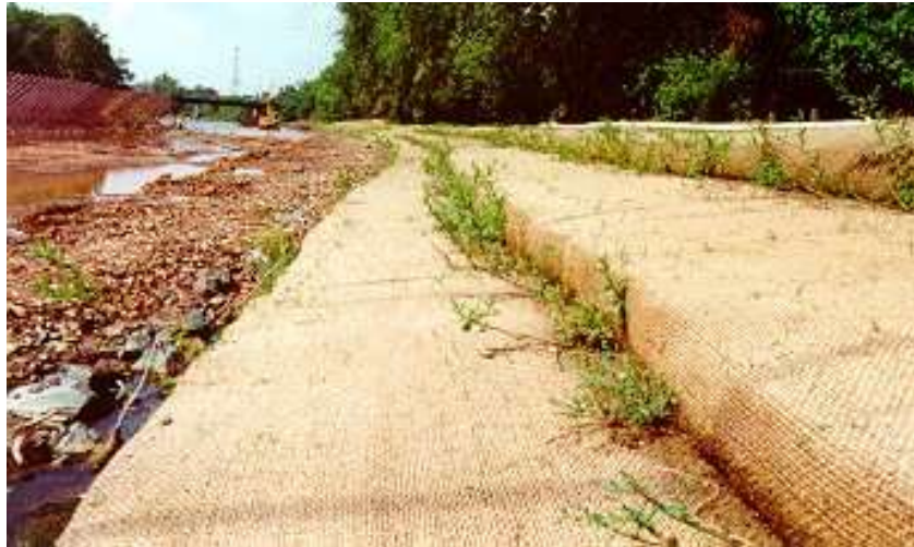
Foto 49. Tela de fibra de coco tejida, usada como protección de cauces de arroyos (España) 55
