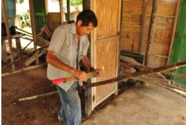
Raspado inicial de la vara - Fotografías: Diego Granados 2011
