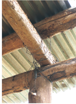
Vigas de arboloco en estructura de construcción
