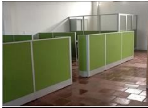
Instalación de los módulos en el nodo de Pitalito. 2015
