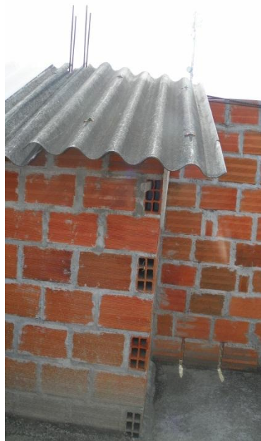
Piso 2 y 3 sin terminar
