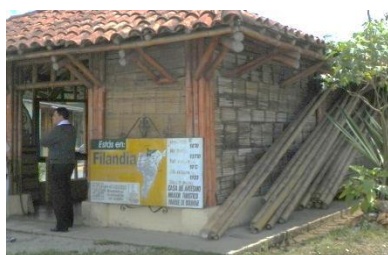
Cerramiento provisional esterilla
