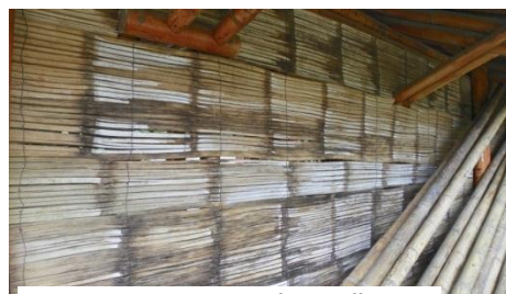
Cerramiento provisional esterilla
