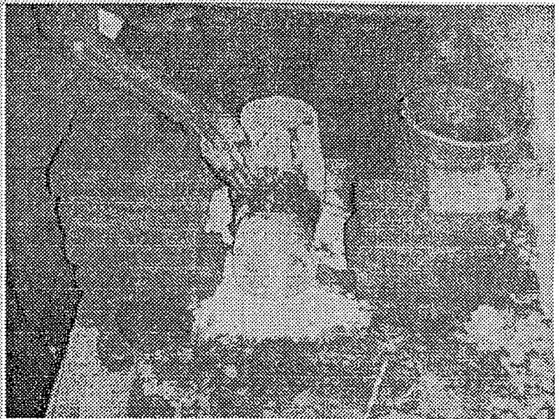
10: The bottom of the cooking surface has angle iron welded to it and sealed. - El fondo de la plancha se hace de angulo cuadrado, sellado y con soldadura
