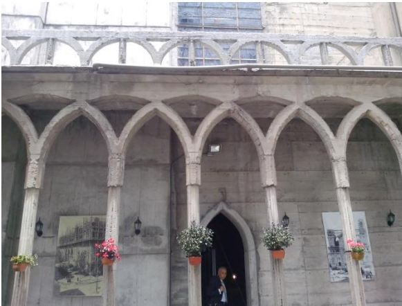
Arcos arquitectura interna catedral basílica de Manizales
