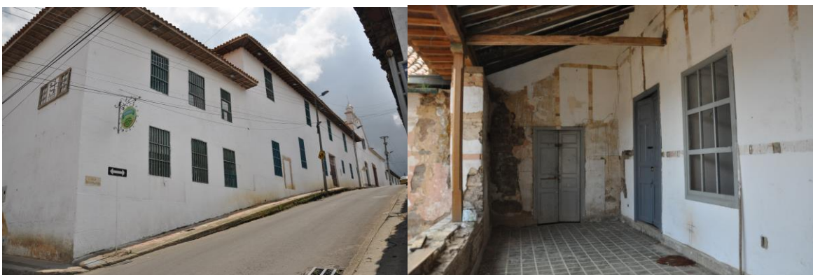
Fachada de la Casa Taller de Boyacá y Exterior de la oficina del Laboratorio de Boyacá.
