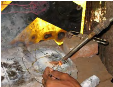
Proceso de soldadura
