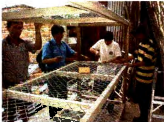
Instruyo a los artesanos en la construcción estructuras de almacenamiento
