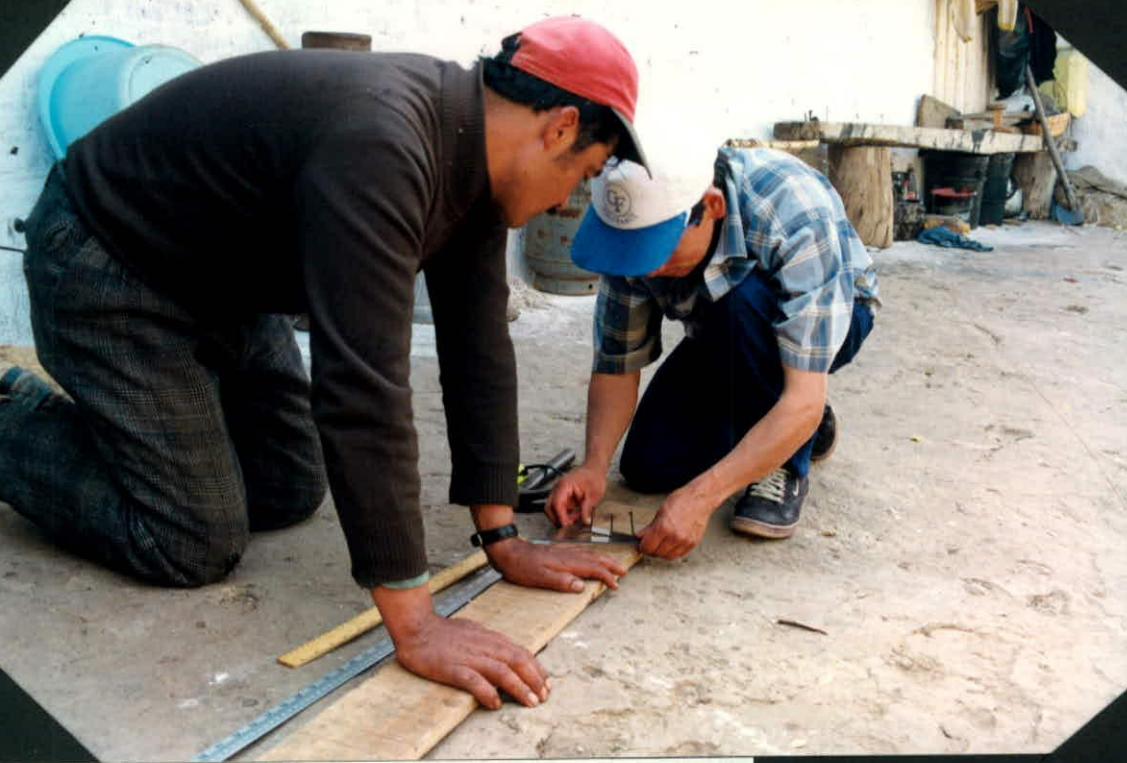
№ 62 Elaboración de Paredes Verticales, gallardetes o Mini-esteras. Se hizo énfasis en que las medidas fueran tomadas correctamente para asegurar uniformidad en los productos.
