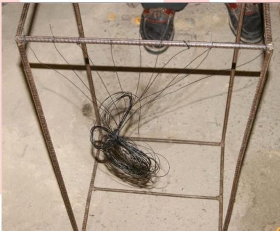
Foto 7. Urdido moldura metálica
