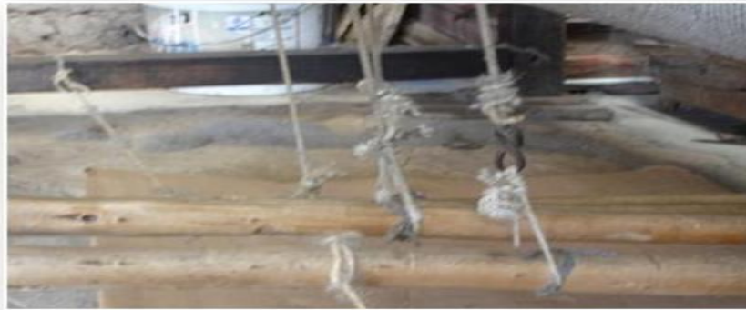
Fotografía No6 Armadura o “enmachado”
