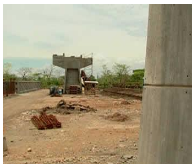
Obras del puente en construcción. Foto Mario Ceballos
