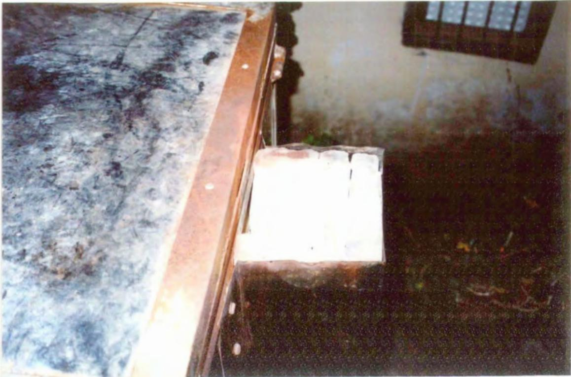
Detalle del daño que sufre el ladrillo refractario y la lamina de la chimenea , grupo Artesa
