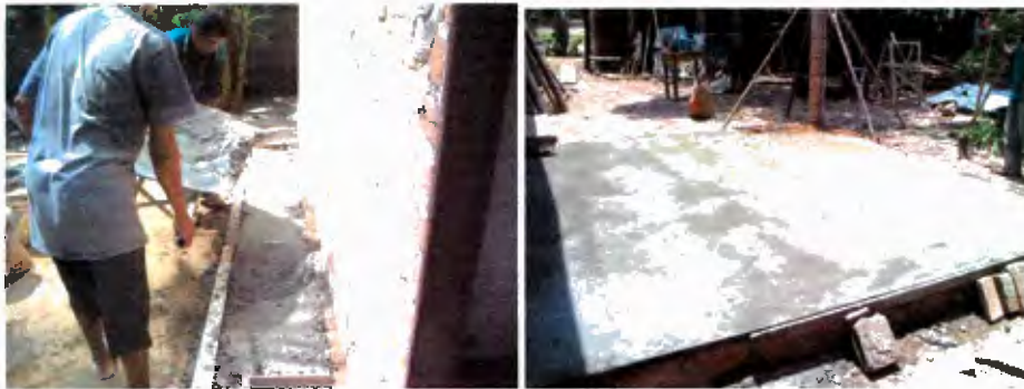
Fundido de placa en cemento de 8 cms de espesor con reborde en ladrillo recocido (área total 3.20 x 3.70)
