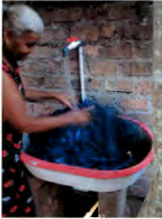
Instalación hidráulica para llenado de tanques y lavado de fibras, lavadero de fibras naturales con poceta en cemento y tubería de agua,
