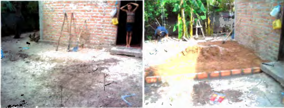
Limpeza y nivelación del terreno para la cimentación de piso.
