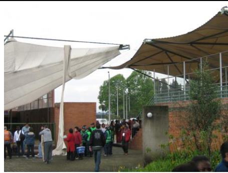
Estado Plaza No. 3 y 4 después de la tormenta
