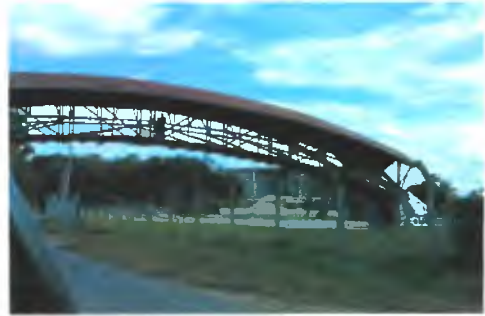
Aplicaciones arquitectónicas. Puente UTP
