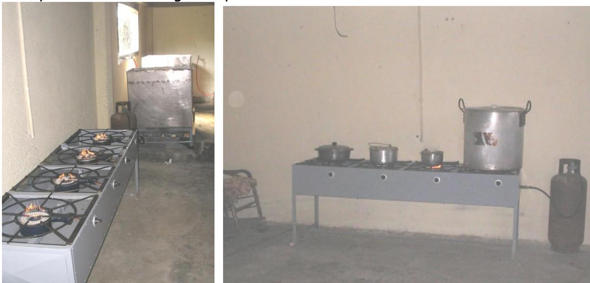
Dotación e instalación de acometida para gas natural (semi industrial) para estufas y calderas.
