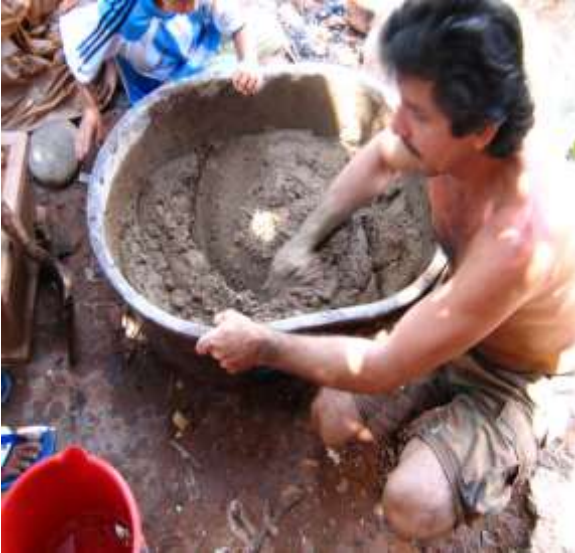
Preparación de mezcla para pegar ladrillos
