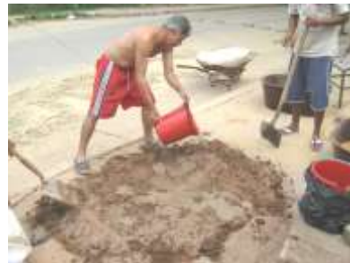
Agregado de agua para mezcla cemento
