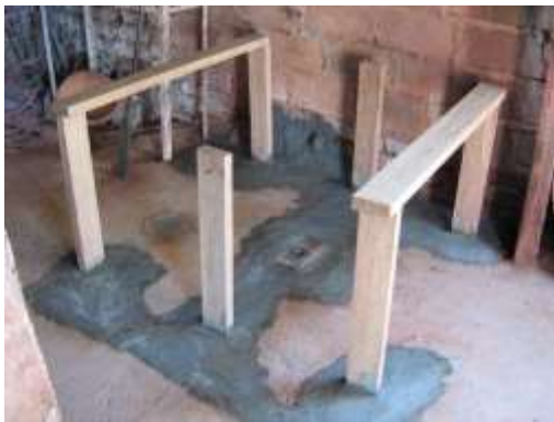
Instalación de estructura nueva de madera. Foto D.Añez
