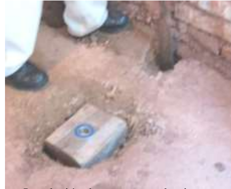
Instalación de taco con rodamiento nuevo Foto D.Añez
