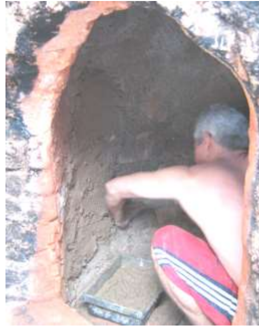
Reparación de horno de Ángel Vega
