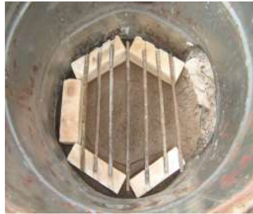
Varillas metálicas para segundo piso
