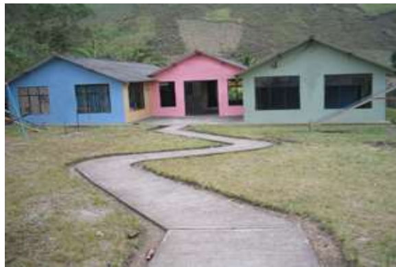
Sede para el montaje de los equipos en Linares
