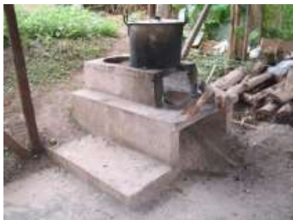
Caldera que funciona con leña instalada en la Umata de Linares, utilizada para el cocinado de la fibra
