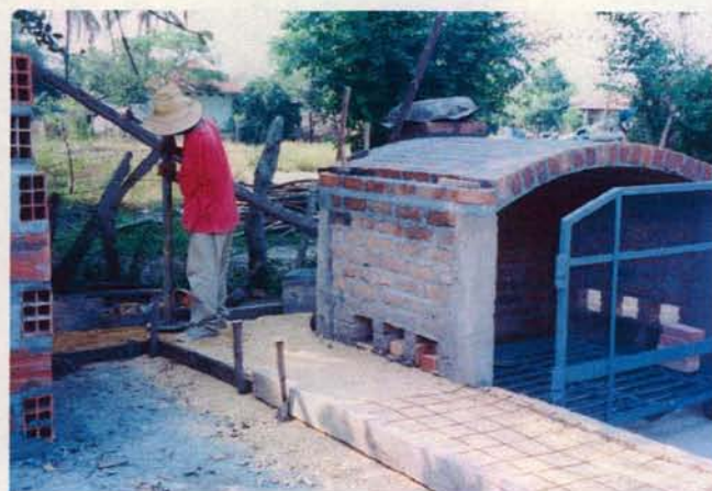
Construcción de horno/ La Chamba - Tolima
