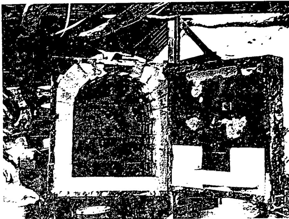
Terminada la curva del techo se continuó con la puerta, colocando los ladrillos refractarios correspondientes.
