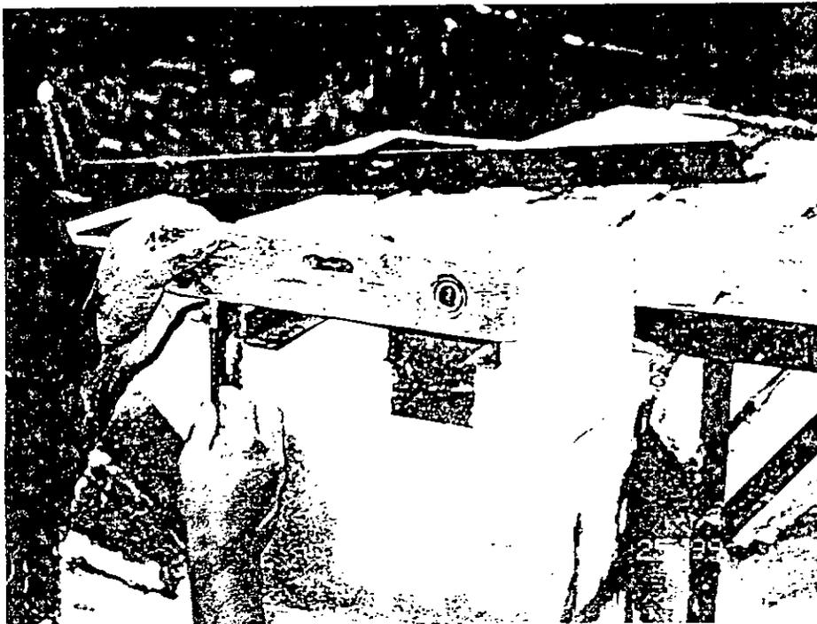
Correspondiendo con la altura externa del horno se colocó la trampa que regula su tiraje.
